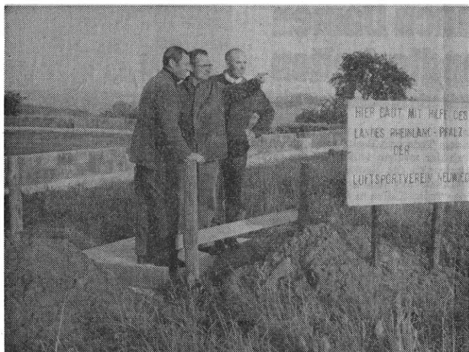
Den Flugplatzbau läßt sich Bürgermeister Jung (links) hier vor den Hallenfundamenten auf der Wienauer Höhe vom Vorsitzenden des Luftsportvereins Neuwied, Rolf Petry, und Fluglehrer Günter Büch fachgerecht erläutern.
